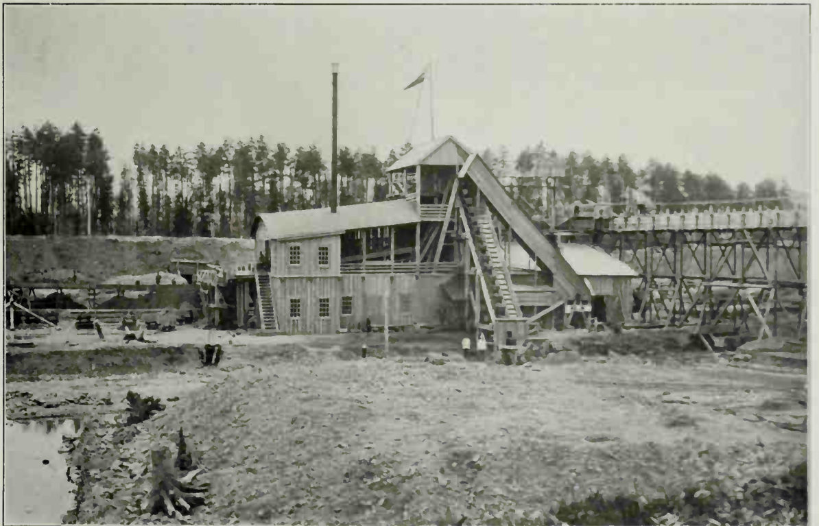
b) Exploitation. Laverie mécanique à trommel, avec chaîne élévatrice à godets. Laverie de Nijne-Issowskoï sur la rivière Iss.
