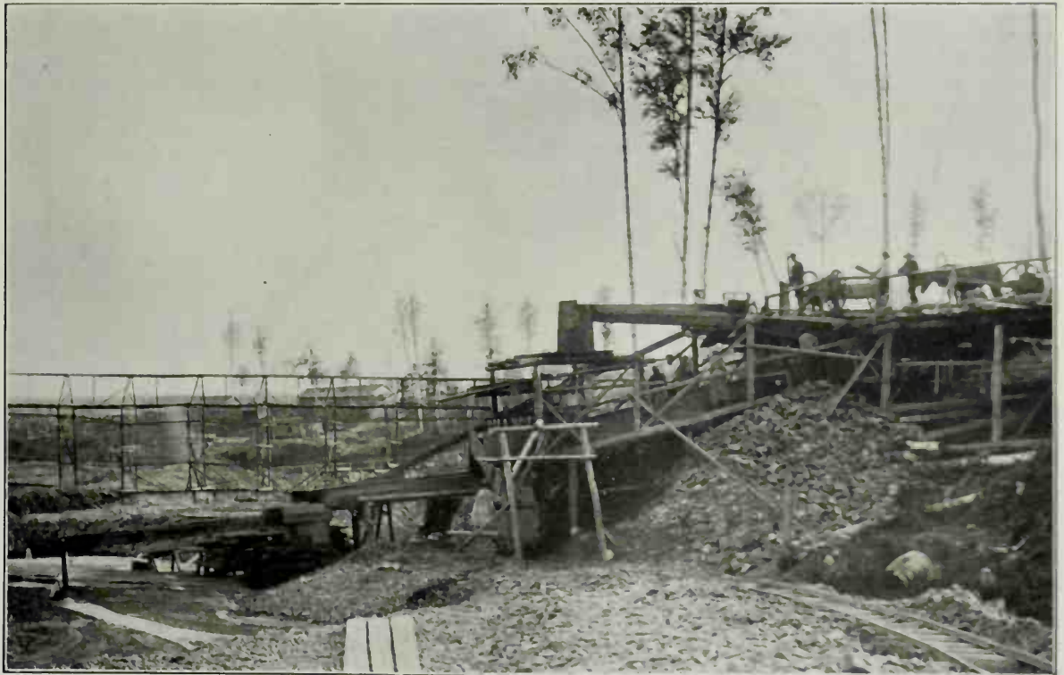
b) Exploitation. Sluice dit « amerikanka » à Petropawlowsky-prisk sur la rivière Iss.
