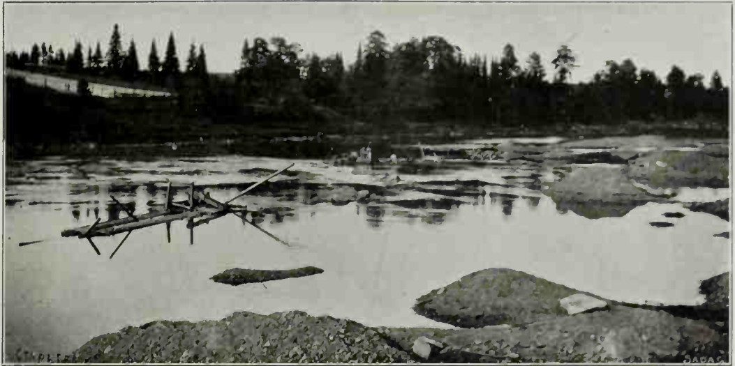
a) Exploitation. Exploitation des alluvions dans le lit contemporain par la pelle sibérienne.
