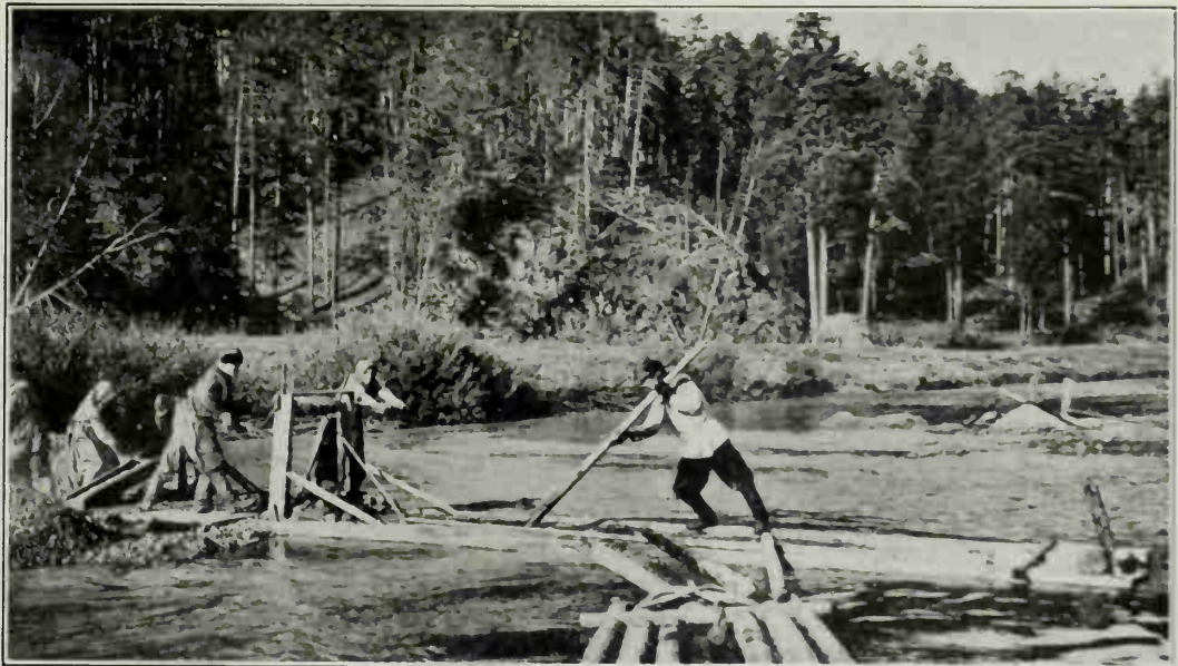
b) Travail à la pelle sibérienne (d'après l'ouvrage de M. N. Wierzbicki, 1904).
