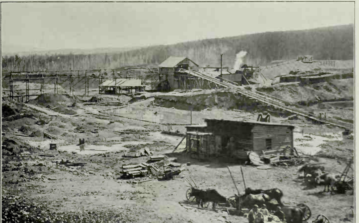
a) Exploitation. Lavoir mécanique avec chaîne à godets élevatrice. Laverie d'Oust-Kossinsky, rivière Iss.
