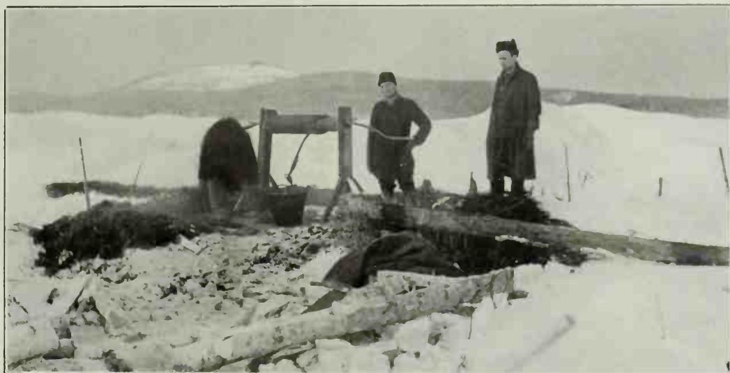
b) Prospection. Puits de prospection (foncée en hiver) sur les alluvions de la rivière Kitlim.
