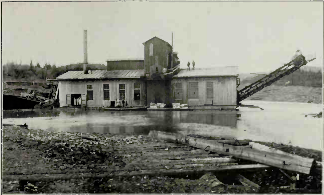
a) Drague N° 1 Braun, du type open-connected, avec godets de 7 pieds cubes, travaillant en lac sur les alluvions de la rivière Martian, à Taguil.
