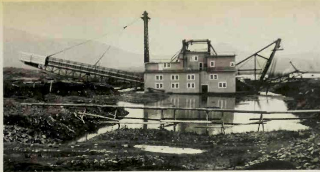
a) Exploitation. Drague électrique modèle de Marion (U. S. A.), avec capacités des godets de 7\frac{1}{2} pieds cubes, travaillant en bassin fermé les alluvions et les tailings de la rivière Kitlim. Pawdinskaya-Datcha.
