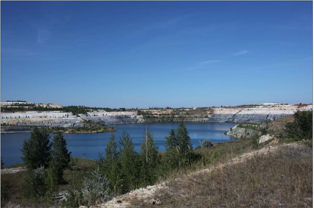
7 aout 2016. Carrière de quartz piézoélectrique d'Astafievskoe
